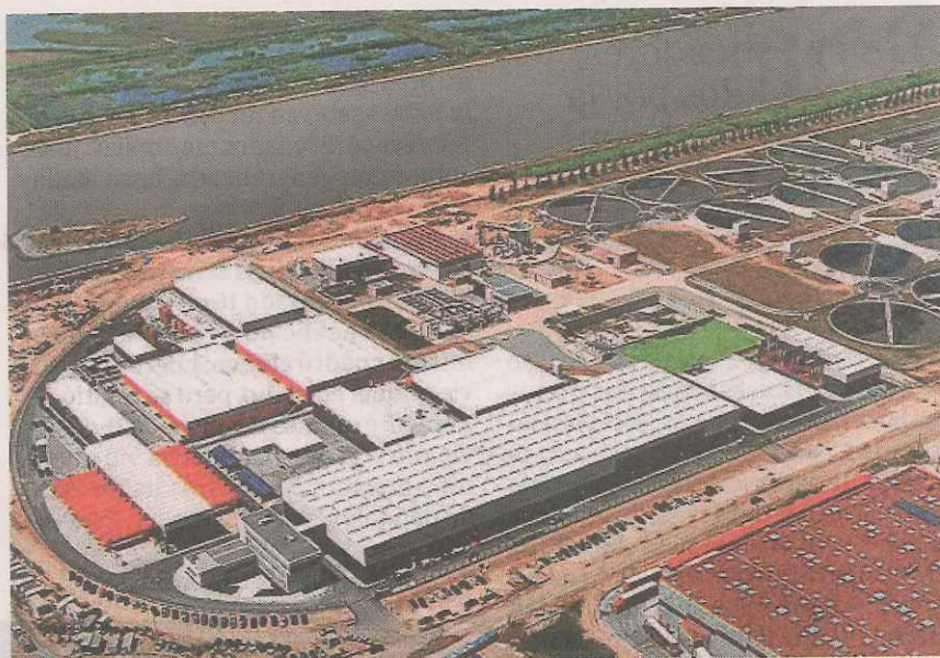
Planta desalinizadora del Llobregat, de la ATLL
